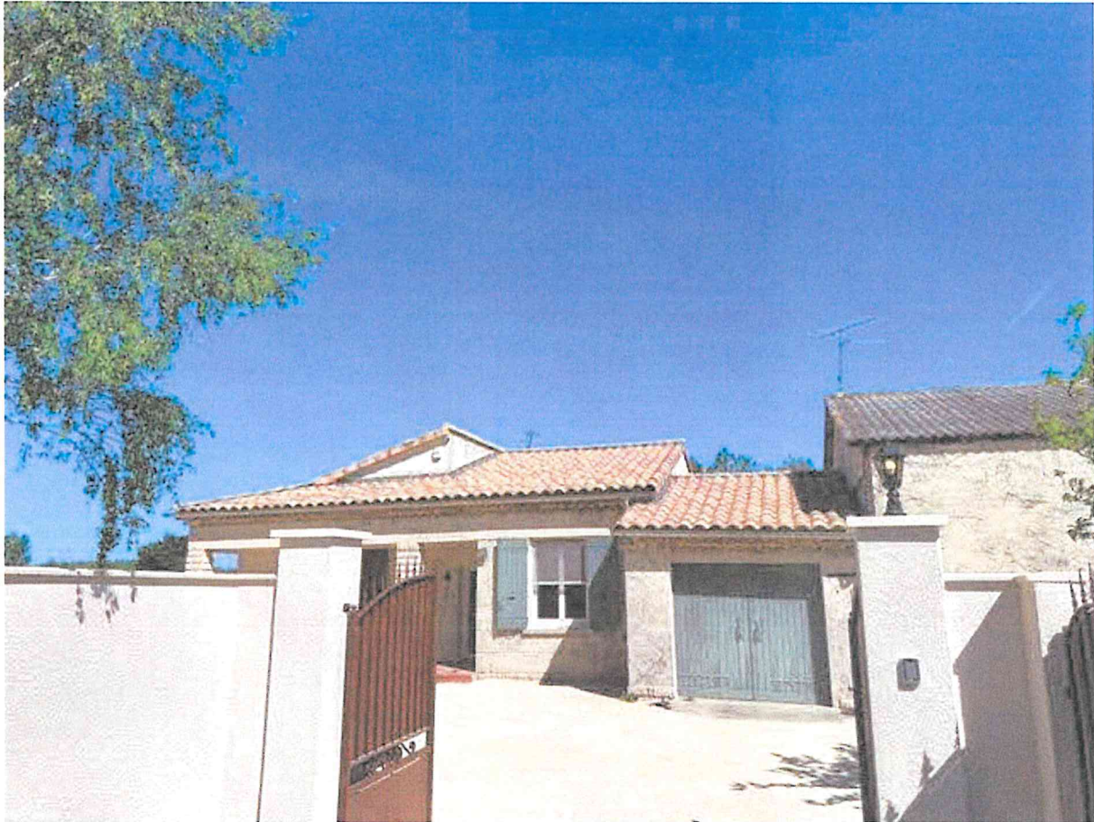
Vue de l'entrée, du mur de clôture enduit et de la toiture.
