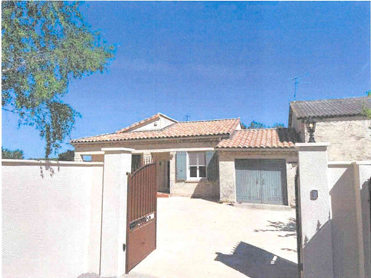
Vue proche depuis la voie sur l'entrée et le mur de clôture.
