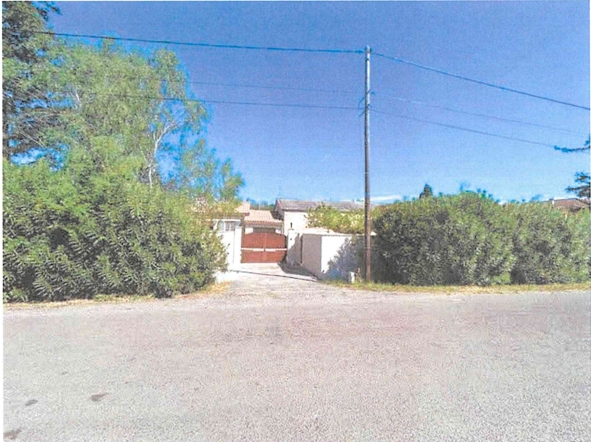
Vue d'ensemble de l'accès et de la limite sur rue.
