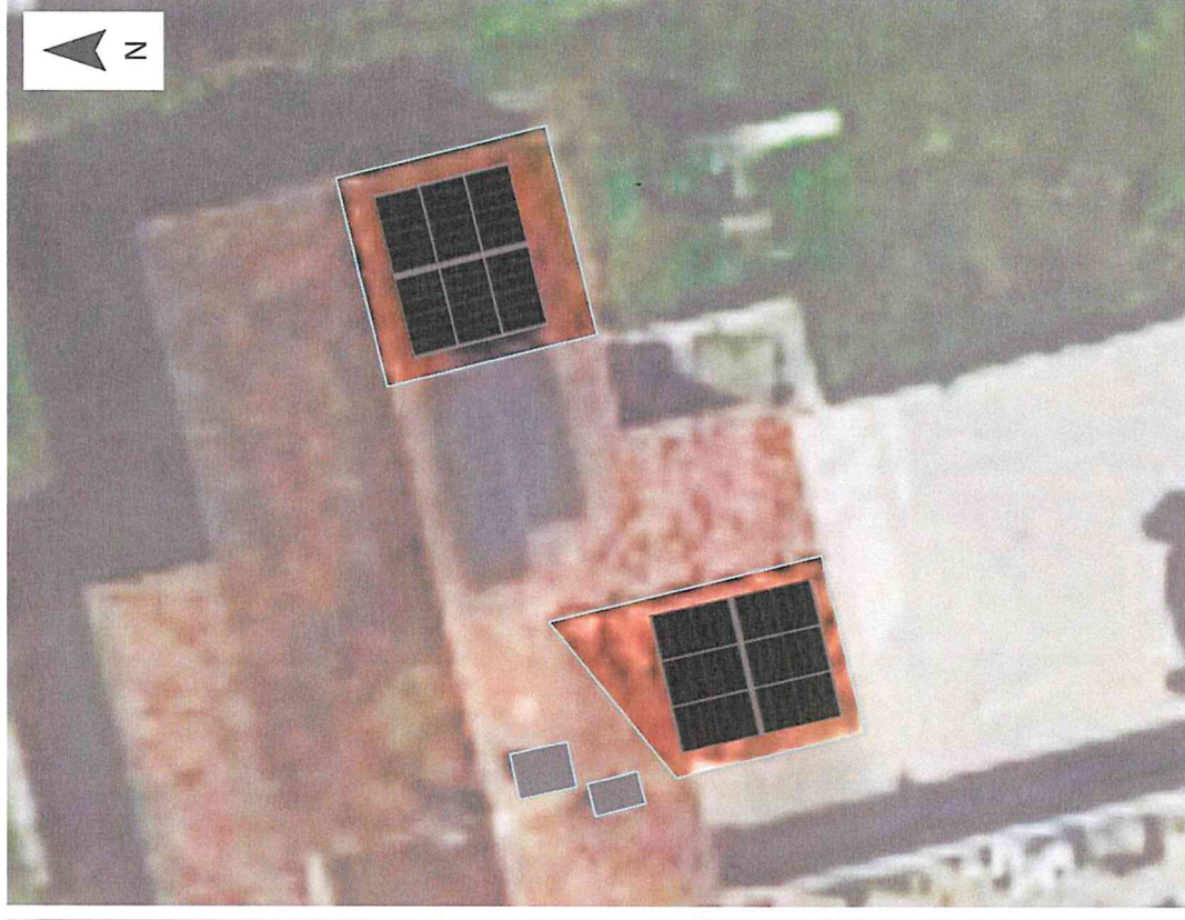
Vue satellite de la construction après installation des panneaux
