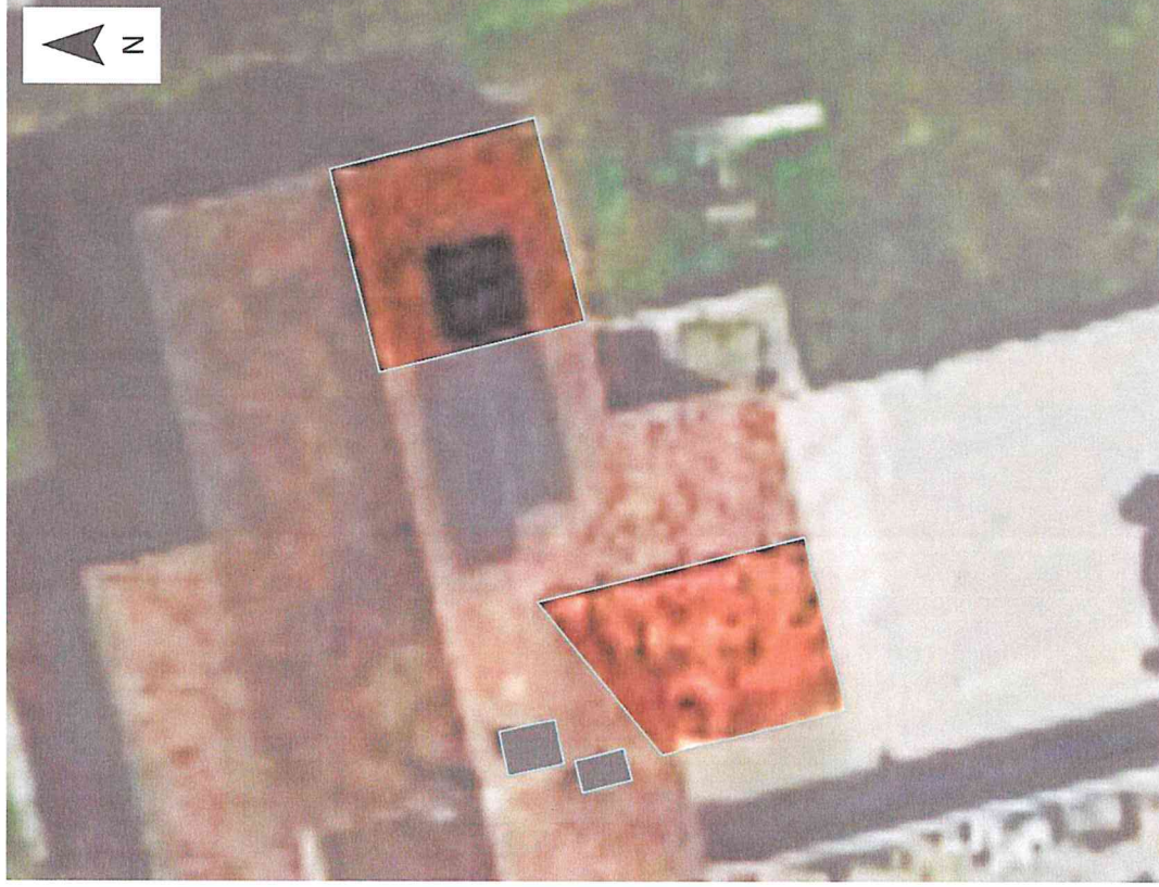
Vue satellite de la construction avant installation des panneaux
