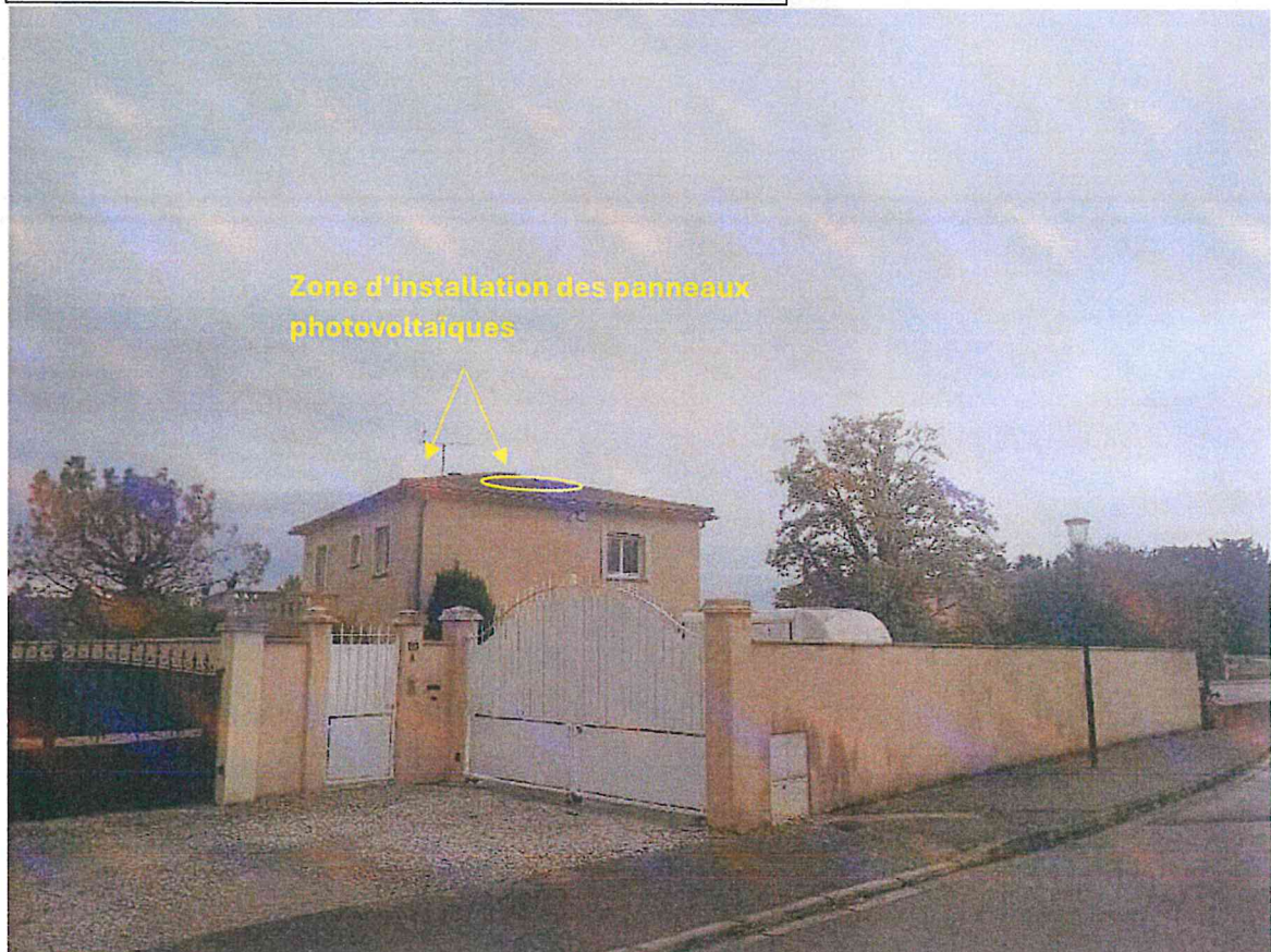
Photo prise depuis la voie publique – Vue sur façade Est
